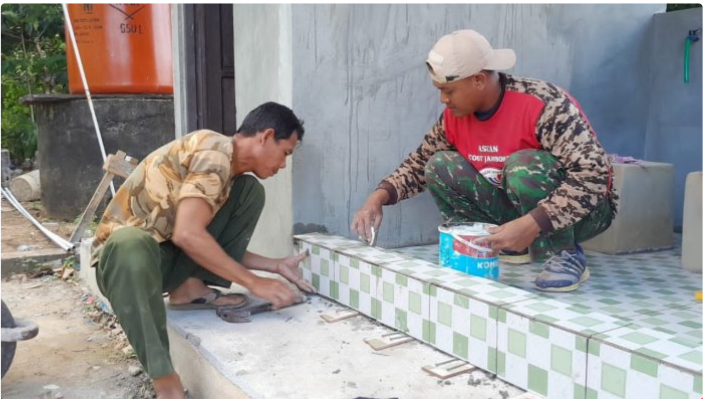
Tak Kenal Lelah, Pengerjaan Rehab TPA Terus Di Kebut
