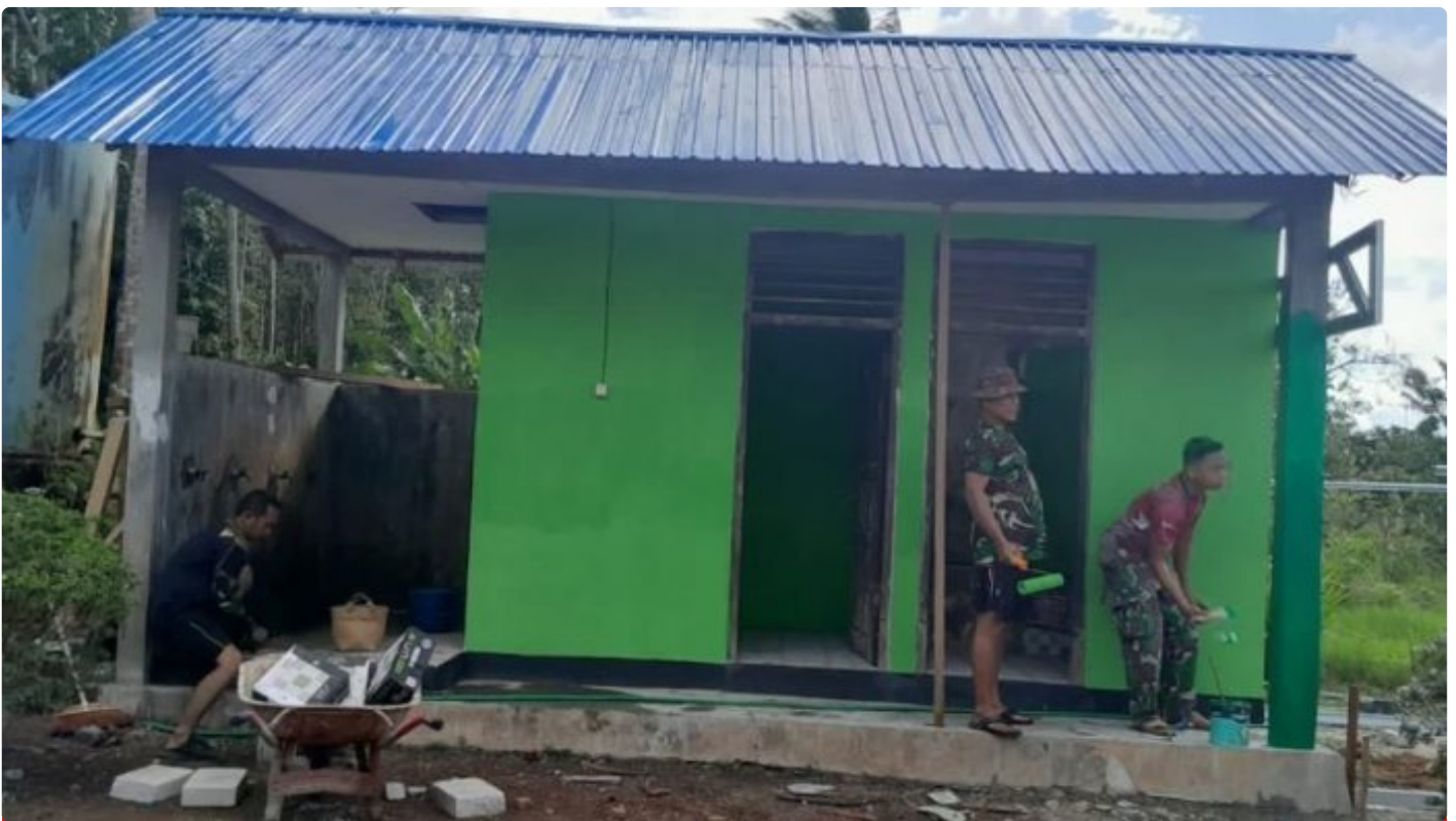
Pengerjaan Sasaran Rehab Masjid, Tinggal Finising
