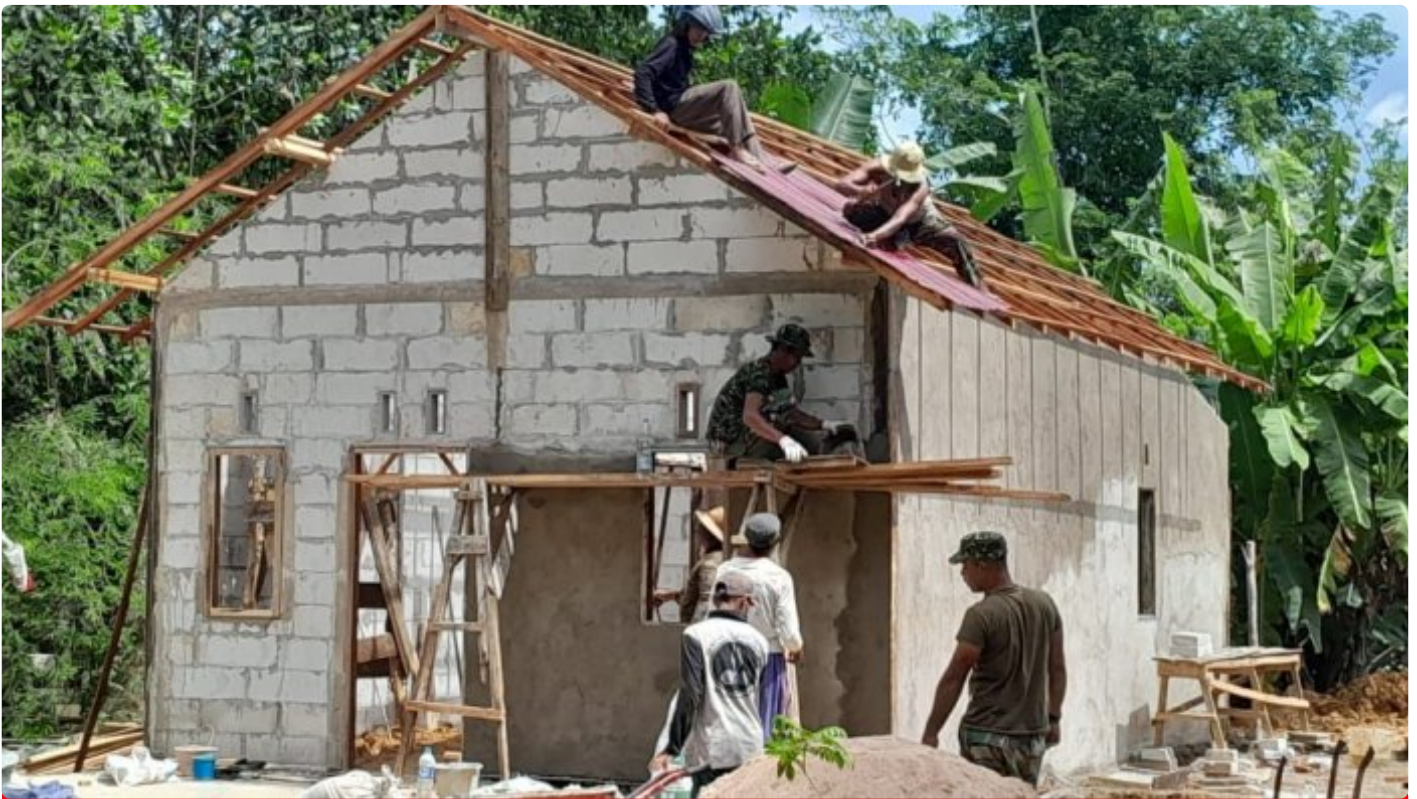
Hari Ke 15, Sasaran Rehab Rumah Sudah Terlihat Hasilnya
