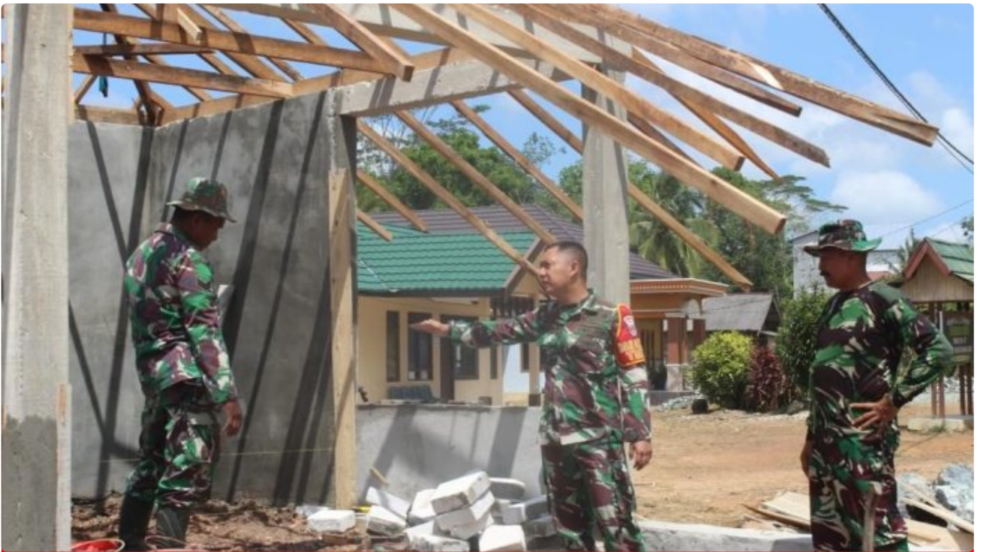
Dansatgas TMMD, Tinjau Langsung Perkembangan Dilapangan
